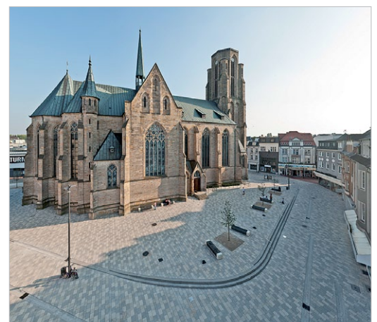
Der St. Urbanus-Kirchplatz vermittelt zwischen der Kirche und den umgebenden Hausfassaden. Foto: Stefan Schrill, Kaarst
