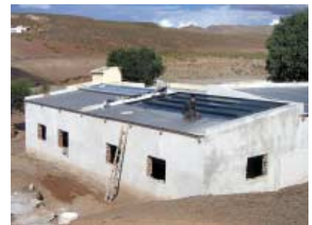
Montage einer Dachsolaranlage
