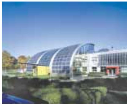
Solarzellenfabrik in Rotthausen/SolarWorld
