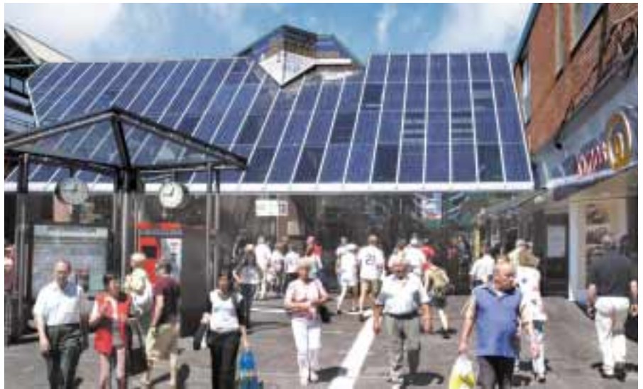
Blick auf die neue Solarstromanlage, wenn man aus dem Bahnhofsgebäude herauskommt und Richtung Bahnhofstraße geht.
