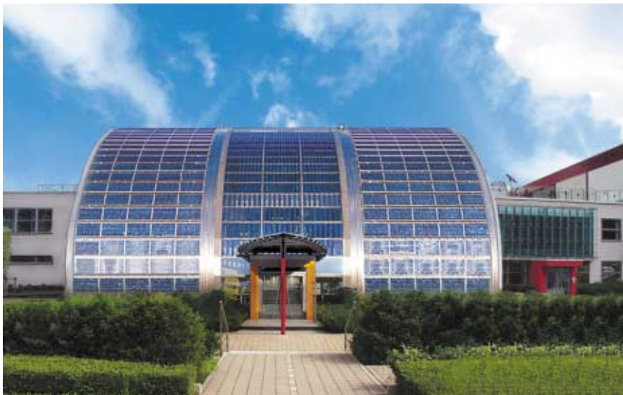
Solarfabrik in Gelsenkirchen-Rotthausen
