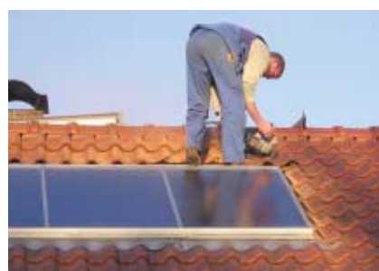
Indachmontage eines Flachkollektors Bildquelle: Westerstede Solar e.V.
