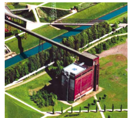
Kohlebunker, ehem. Zeche Nordstern
