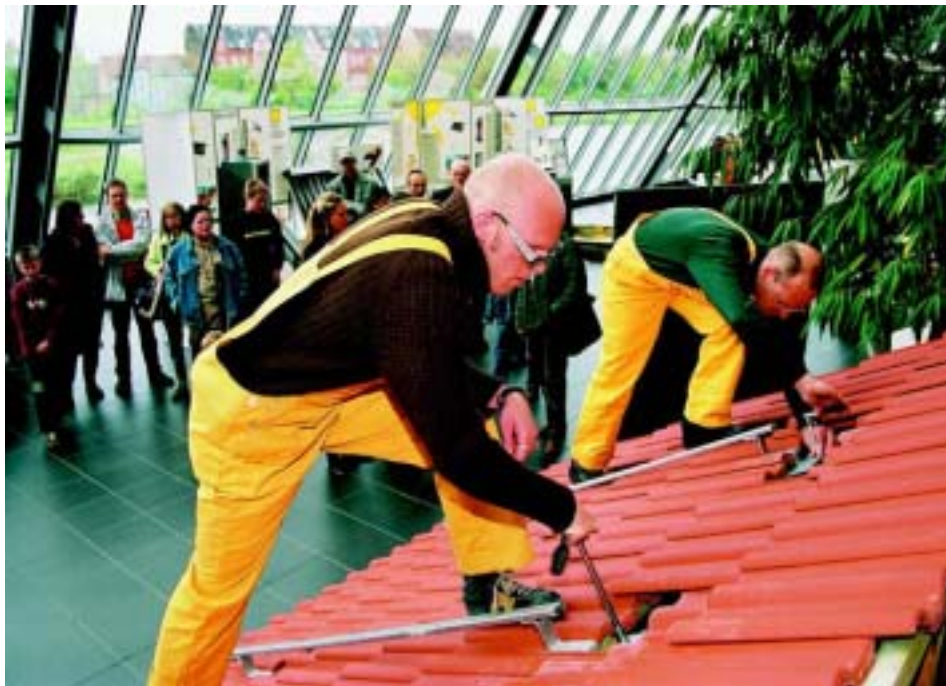
So werden Solarpaneele auf dem Dach montiert: praktische Vorführung auf der megaWatt.
