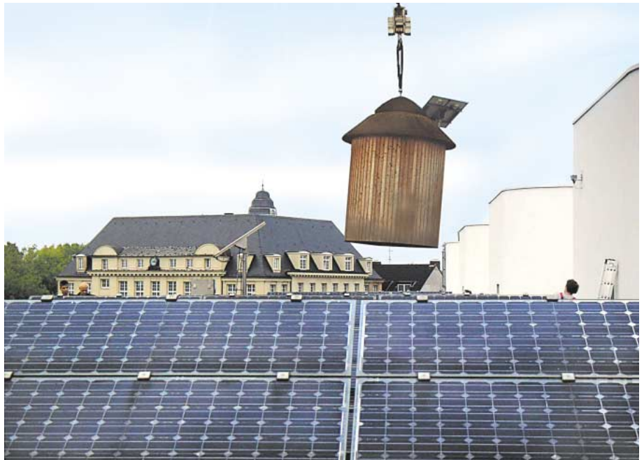
Solarstrom für Afrika: Dieses Exponat wurde 2004 mit der SolarExpo in den Wissenschaftspark verlegt. Das Bauwerk (aus Sauerländer Fichte) zeigt, wie eine Familie in Afrika mit Solarstrom grundversorgt werden kann.
