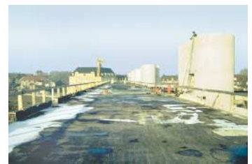
Dacharbeiten vor dem Aufbau
