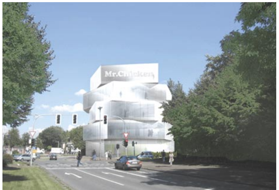
Ein auffälliges Gebäude wird an der Ecke Munscheidstraße den Abzweig zum Wissenschaftspark deutlich markieren. Es werden fünf verschachtelte Etagen mit einer gläsernen Fassade entstehen. Die Hauptzentrale wird ca. 20m hoch werden.
