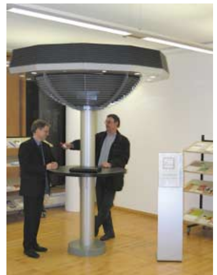
Erinnert an einen Pilz: der GEA-Clarifair vor Pavillion Acht sorgt für Nichtraucherschutz während der Raucherpause.
