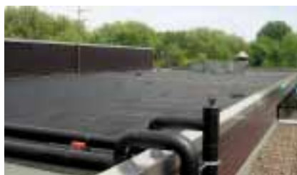
Solarabsorber auf dem Dach des Aktivariums: über 22 Kilometer Kunststoffschlauch wird in erster Linie das Freibadwasser erwärmt.
