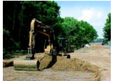
Die Erschließungsarbeiten für das neue Gewerbegebiet sind bereits in vollem Gange. Südlich des Gründungszentrums bereiten Baumaschinen das Gelände auf.
