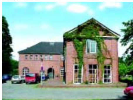
Einst Schaltzentrale für Zechenstrom, dann Hauptsitz der Internationalen Bauausstellung Emscher Park: Das rote Backsteingebäude im Wissenschaftspark, ist für das Team der Kultur Ruhr GmbH ein idealer Standort.
